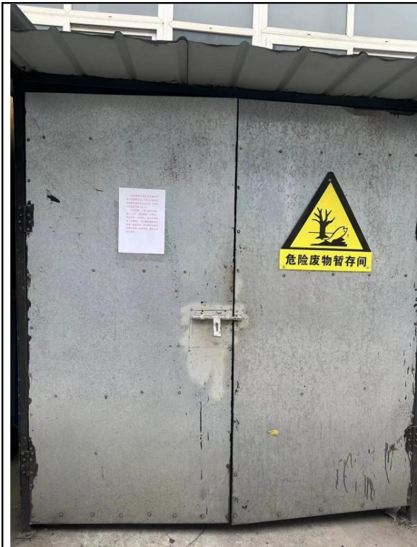
危废贮存设施
