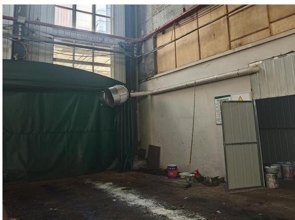
滚涂、晾干及危废贮存废气集气管道
