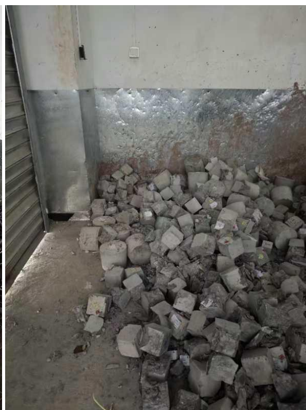
一般固废暂存间
