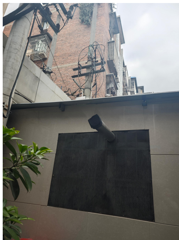
柴油发电机废气烟道
