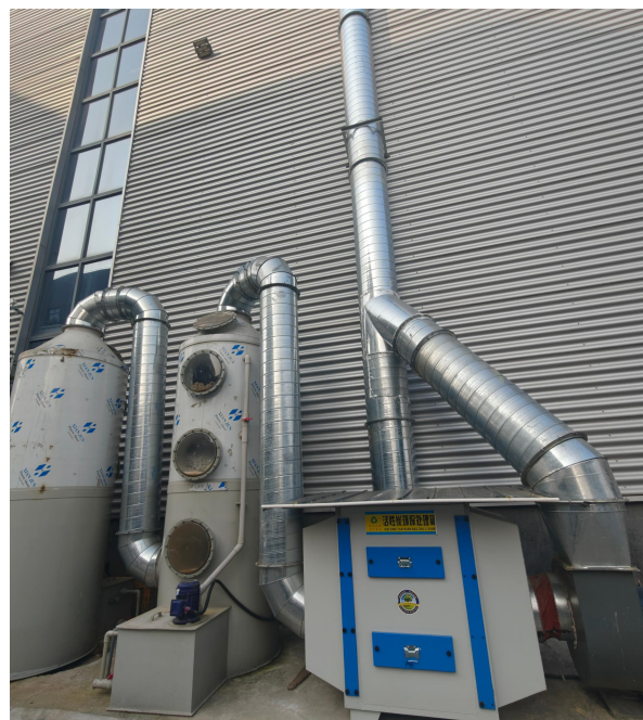
“喷淋净化塔+干式过滤+二级活性炭吸附”废气处理装置+DA001 排气筒
