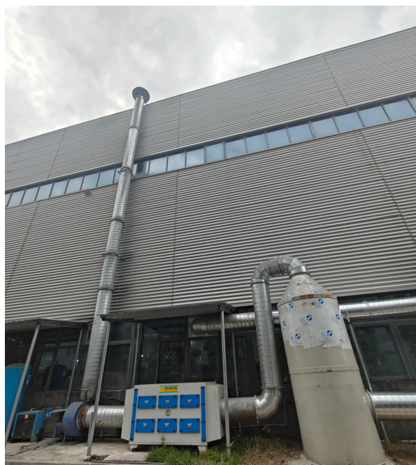
“喷淋净化塔+干式过滤+二级活性炭吸附”废气处理装置+DA001 排气筒
