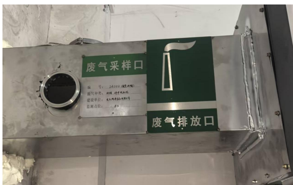
食堂油烟集气罩+2#油烟净化器+排气筒 (DA003)
