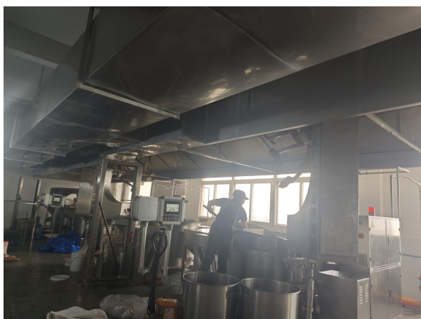
炒锅天然气燃烧废气及炒制废气集气罩+1#油烟净化器+排气筒 (DA002)
