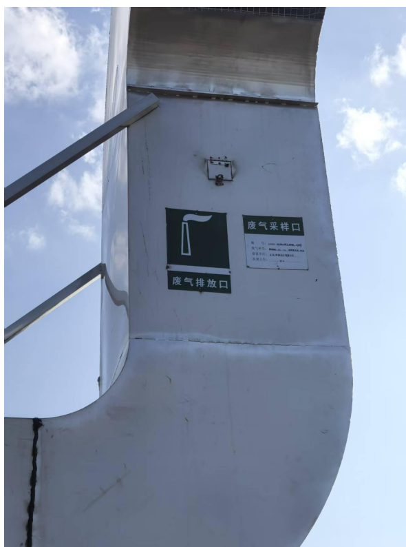
炒锅天然气燃烧废气及炒制废气排放口及标志牌
