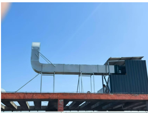
炒锅天然气燃烧废气及炒制废气集气罩+1#油烟净化器+排气筒 (DA002)
