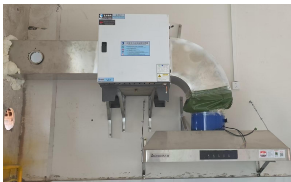
食堂油烟集气罩+2#油烟净化器+排气筒 (DA003)
